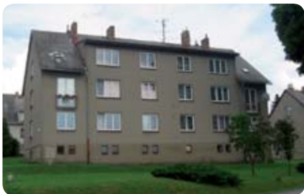
Původní stav bytového domu
