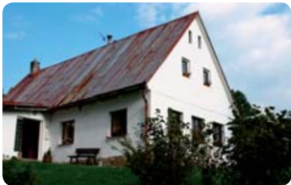
Původní stav rodinného domu
